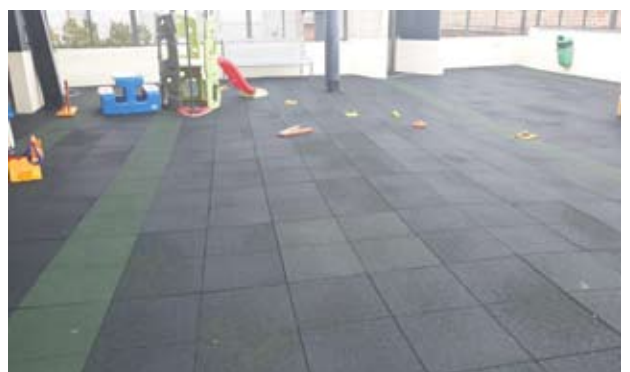
Impermeabilització a l'escola Lanaspà
