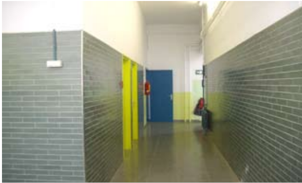
Treballs de Pintura a l'escola Bisbat d'Ègara
