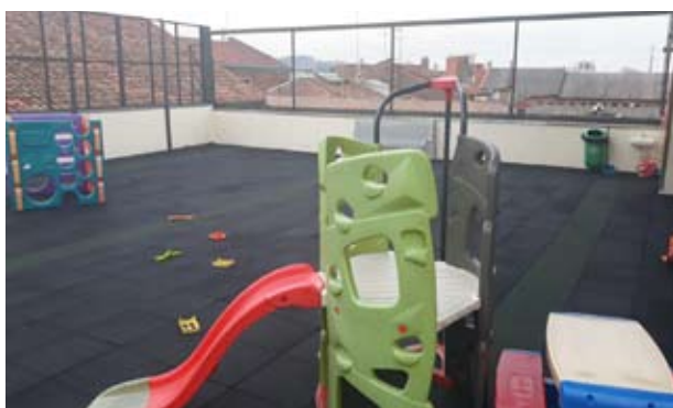
Impermeabilització a l'escola Lanaspà
