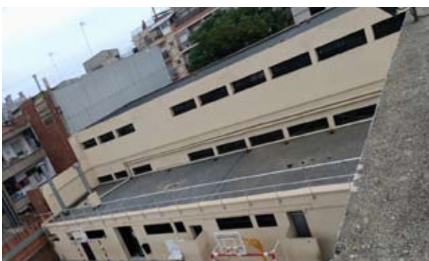
Impermeabilització a l'escola Ramon y Cajal
