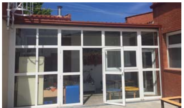
Coberta unió edificis EBM La Casona
