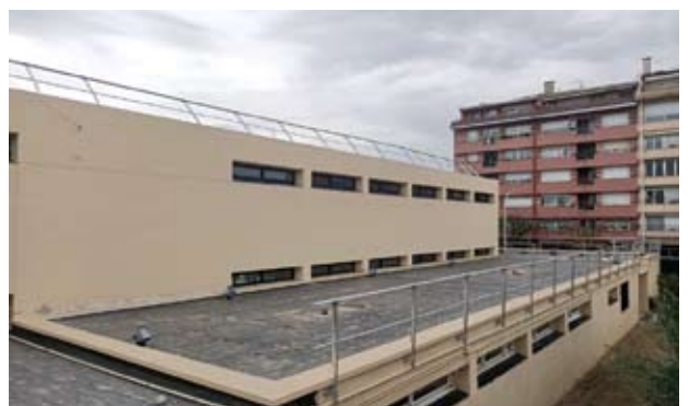
Impermeabilització a l'escola Ramon y Cajal
