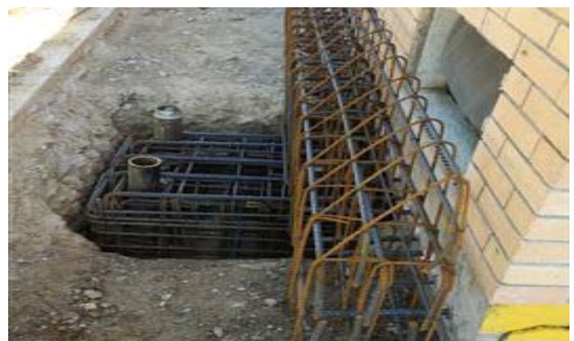
Cimentació de la sala de calderes a l'escola Pau Vila
