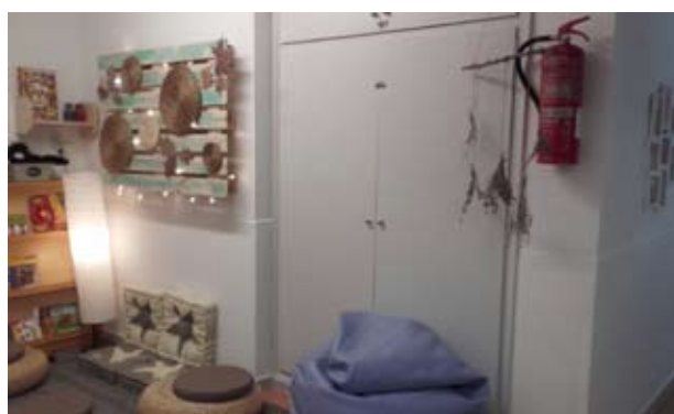
Treballs de pintura a l'EBM Espígol
