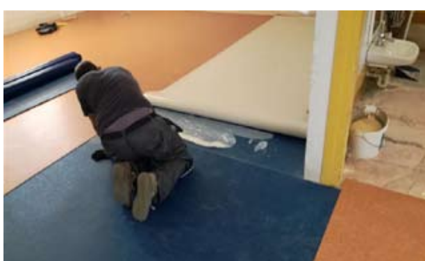
Substitució de paviments a l'EMEE El Pi
