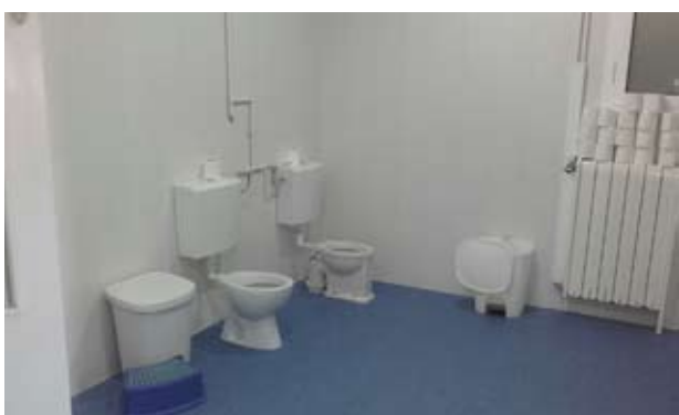
Reforma dels lavabos a l'EBM Espígol
