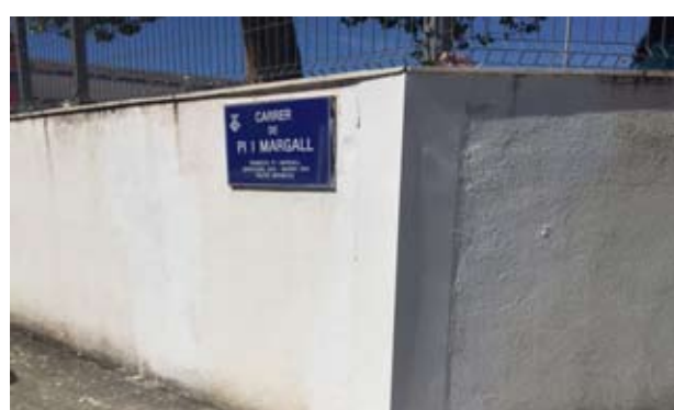
Reparació façana de l'Escola França
