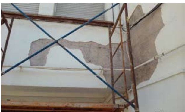
Reparació façana de l'Escola Bisbat d'Egara
