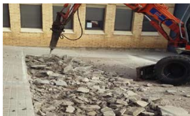
Pavimentació Pati Escola Marià Galí
