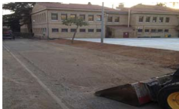
Pavimentació pati de l'Escola Josep Ventalló
