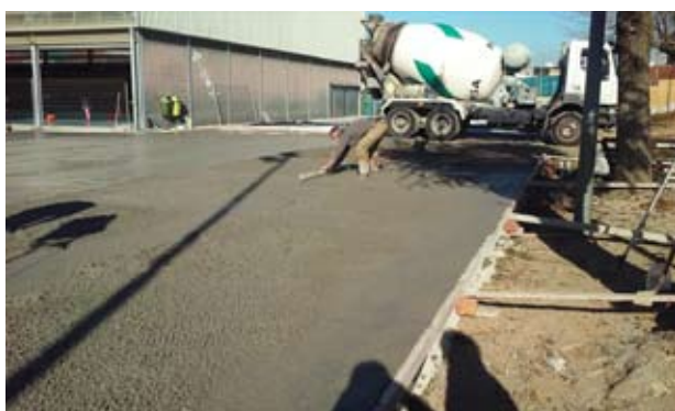
Pavimentació pati de l'Escola Josep Ventalló
