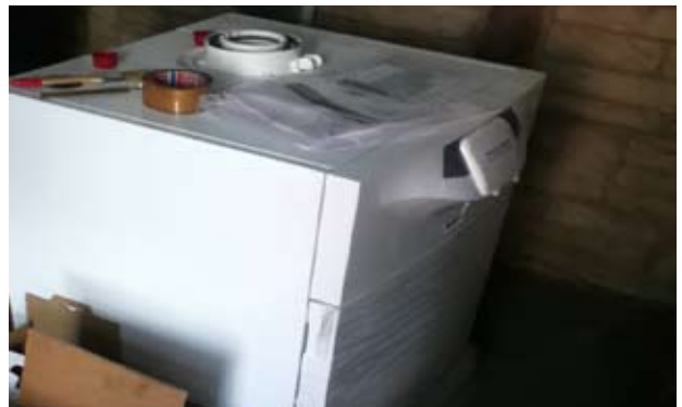
Substitució de caldera a l'EBM Giravolt
