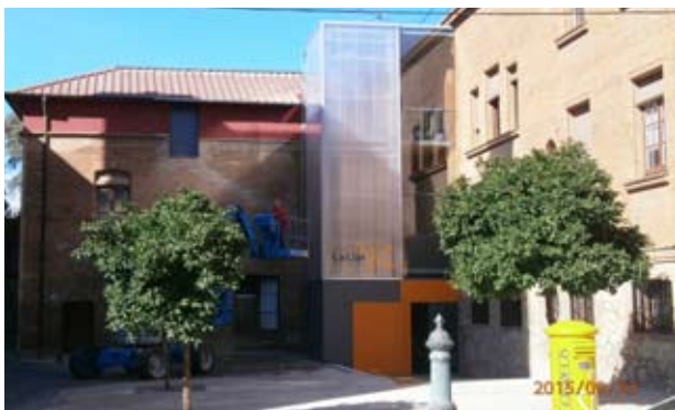
Obra d'accessibilitat a l'Escola Mpal. La Llar
