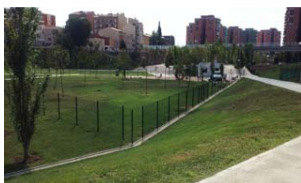
Tancat per pati Escola Sala i Badrinas
